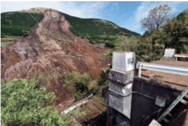
立野側の大規模な土砂崩れで、橋桁が崩れ落ちた阿蘇大橋 (2016年4月17日付 熊本日日新聞朝刊)
