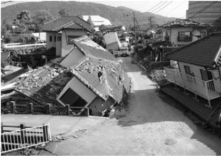
倒壊した家屋（益城町）
