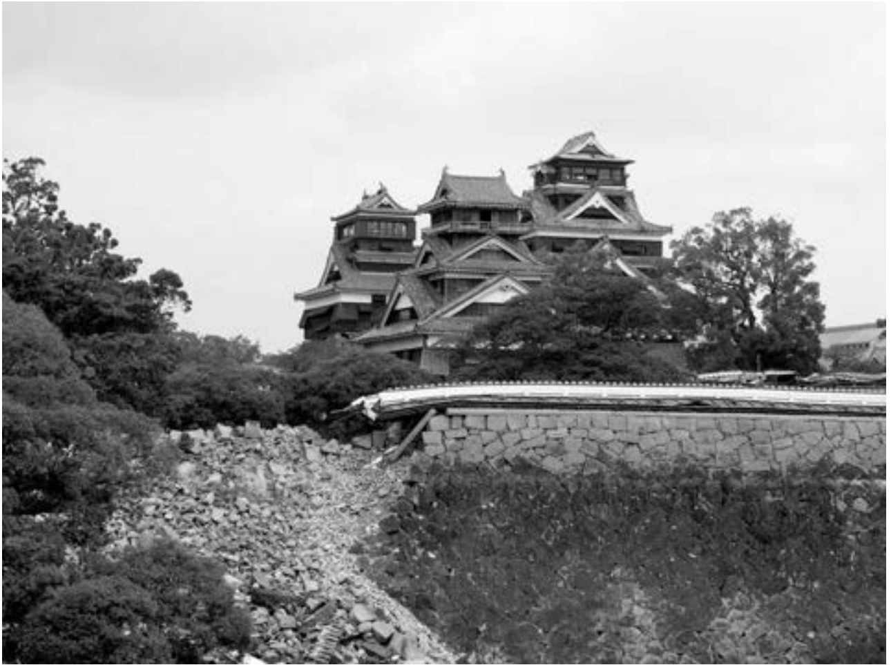
崩落した熊本城の石垣
